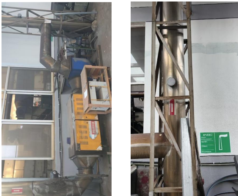
图 4.1-2 热处理废气治理设施
