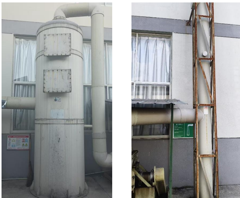
图 4.1-6 挤出废气治理设施
