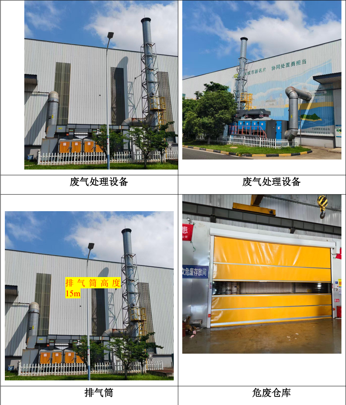
图 9-1 企业车间现场、废气处理设施和危废仓库现场照片
