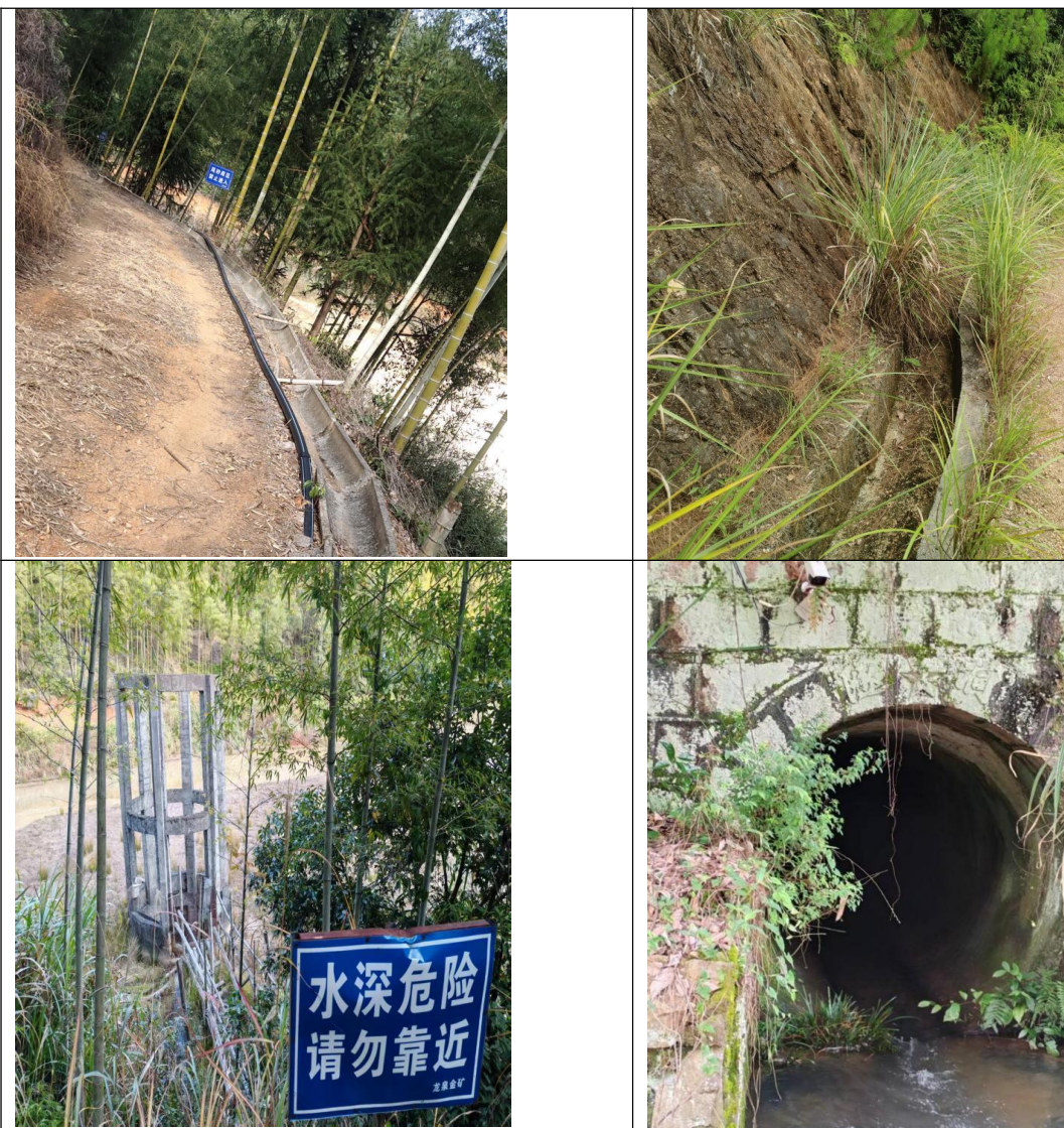
图 3.9-1 尾矿库截洪、排渗设施现状
